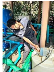
รูปภาพ : ตรวจสอบรอยรั่วของท่อจ่ายน้ำ บริเวณรอยต่อและปั๊มสูบน้ำ เพื่อลดการสูญเสียการใช้น้ำ
